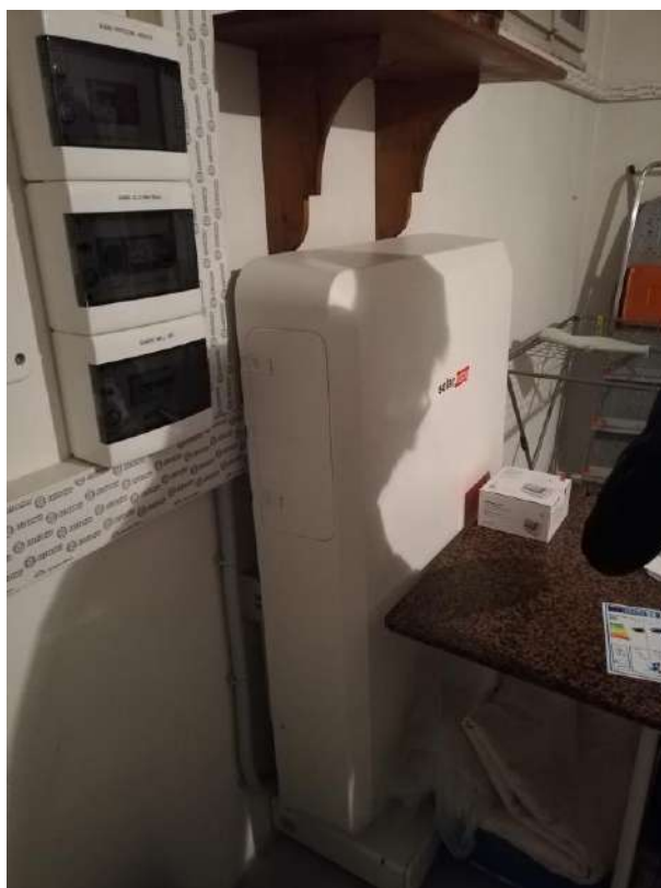
Figura 6 - Installazione batterie di accumulo
