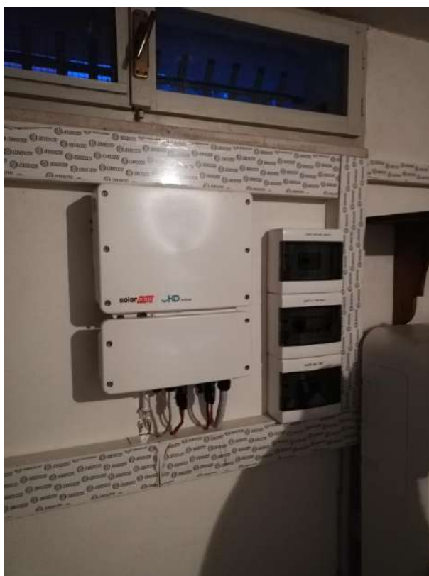
Figura 7 - Installazione inverter
