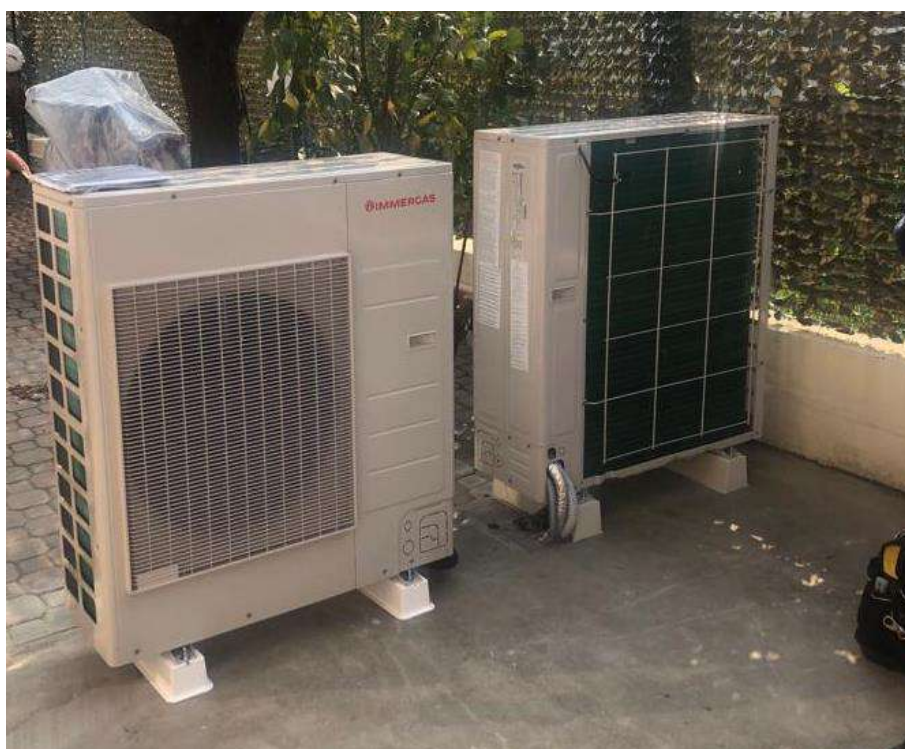
Figura 3 - Unità esterna sistema ibrido
