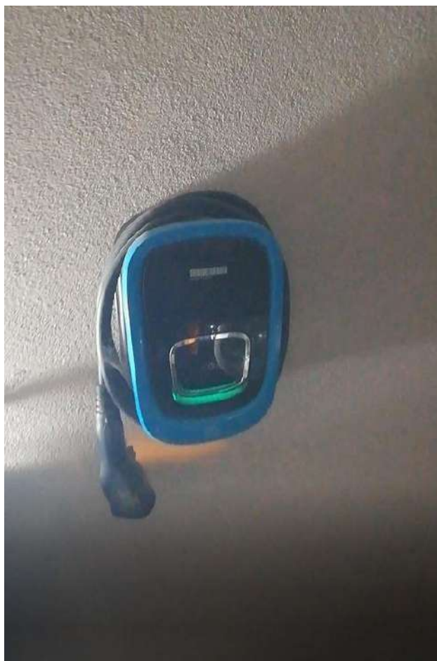
Figura 8 - installazione colonnina ricarica auto
