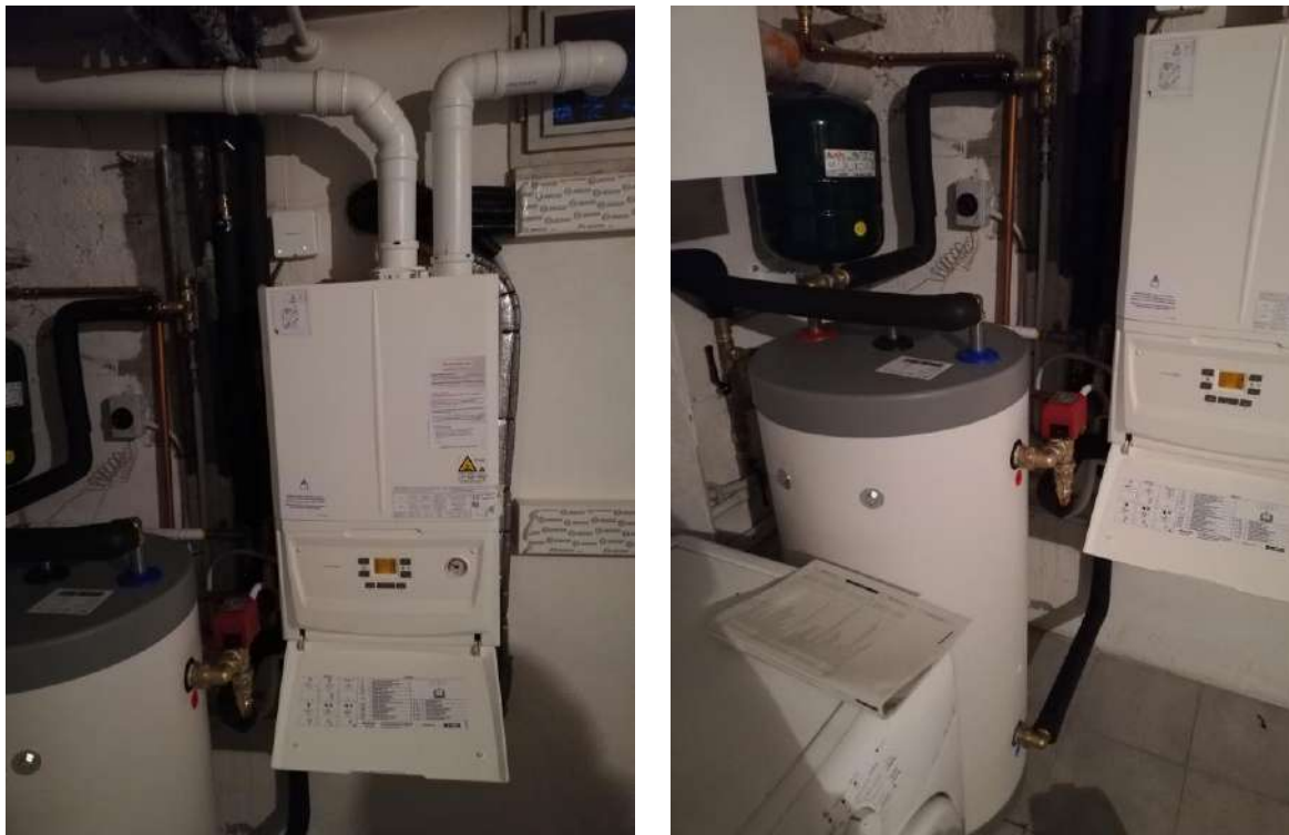
Figura 2 - Unità interna e bollitore sistema ibrido
